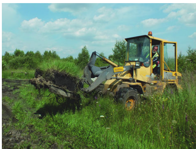
Fig. 1. Przenoszenie bloków murawy z terenu budowy (publikacja 1.I).
